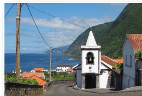
Ermida de São João São João chapel
